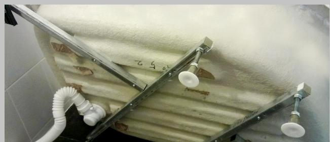
Рама изготовлена из тонкой трубы, толщиной 0,5 мм., зачастую состоит из нескольких элементов, что резко снижает прочность конструкции и сокращает срок службы изделия.
